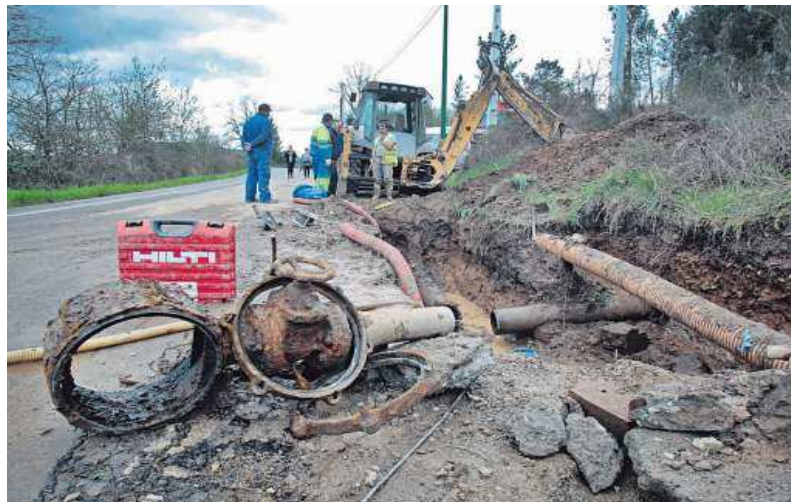
Fotografía de archivo de la reparación de una fuga de agua en la traída municipal de Monforte. c.c.
