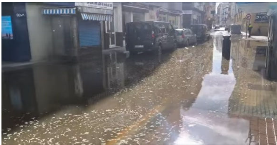
Una tubería revienta en La Línea.
